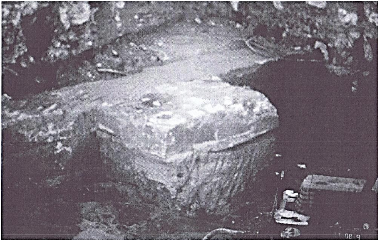
Flanco oeste de la cerca urbana que se conserva por debajo de la cota de la calle. Para combatir la fuerza del agua del río, estas murallas estaban reforzadas con torres al interior.
